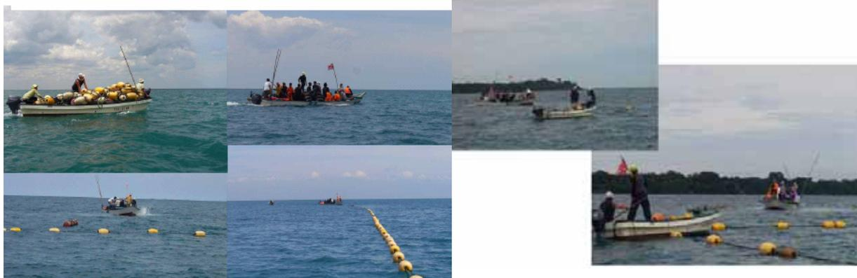
図 8 氷見市寄贈の小型 FRP 船と現地建造の網起こし船による側張り設置作業
